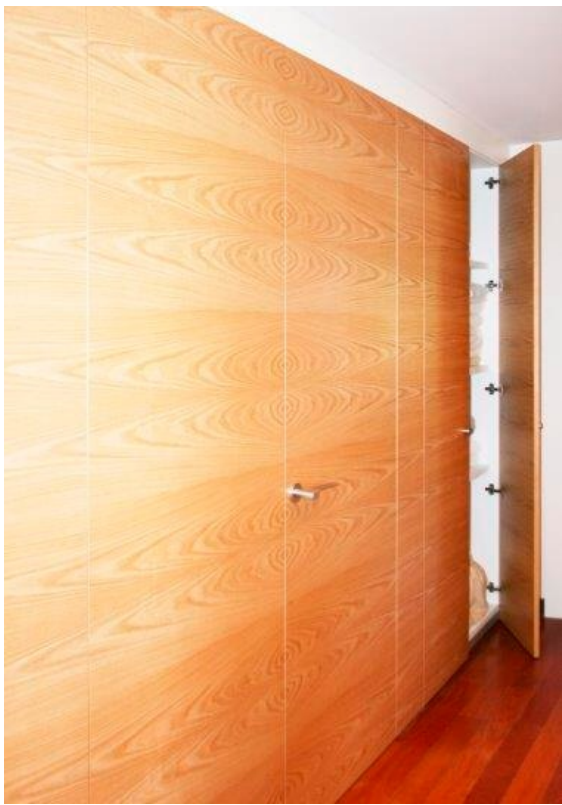
Doble puerta de acceso a dormitorio principal con puertas anexas de armarios en chapa de roble americano colocada a través. La continuidad del dibujo de la chapa de madera consigue transformar un frente compartimentado en un frente único. Fotografías Grupo Gubia. Todos los derechos reservados
