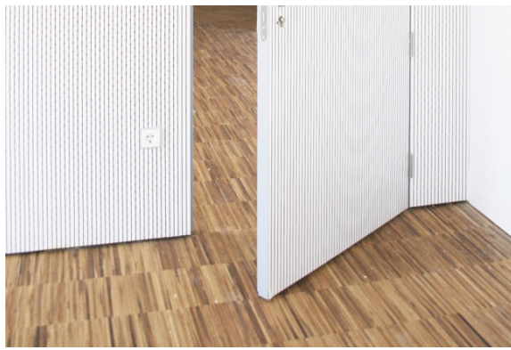
Puerta acústica de madera a medida terminada en tablero melamínico blanco fonoabsorbente. Fotografías Grupo Gubia. Todos los derechos reservados.
