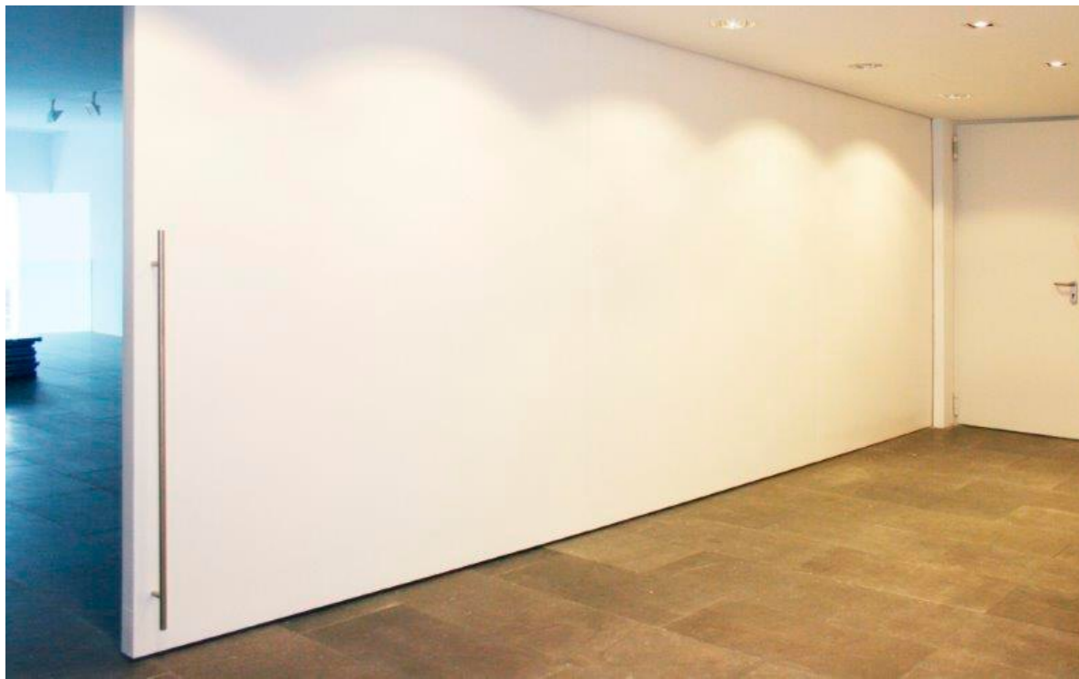
Puerta corredera de gran dimensión de 7,20x2,30m. Realizada con tableros de MDF atamborados interiormente con una cuadrícula del mismo material, consiguiendo un espesor final de hoja de 8cm. Fotografías Grupo Gubia. Todos los derechos reservados.
