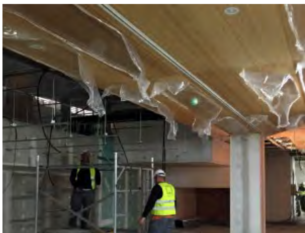
Proceso del montaje del techo del Pompidou, en el que Grupo GUBIA ha instalado tableros acabados en chapa de bambú suspendidos mediante varillas metálicas que permiten que estos sean registrables.
