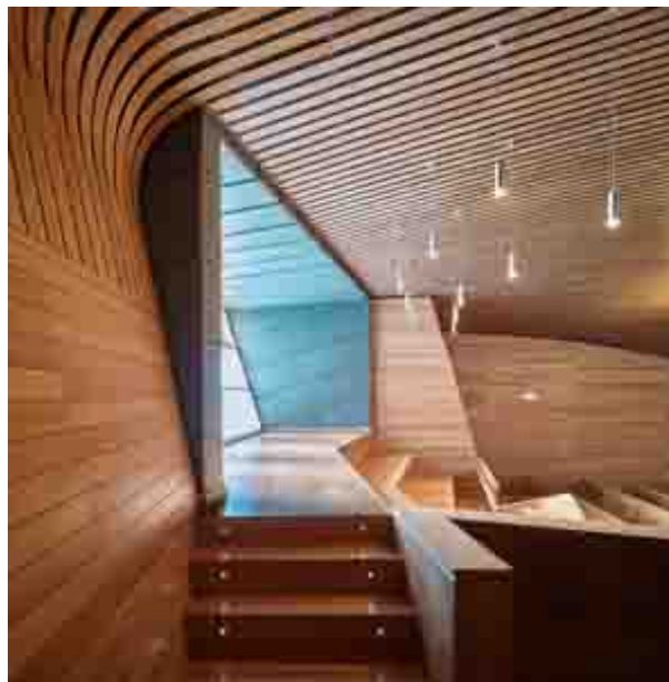
Revestimientos y carpinterías a medida diseñados por Hermoso & Heimannsfeld, de Artytech2, y ejecutados por Grupo GUBIA en bambú. Su extrema flexibilidad y resistencia han permitido moldear un espacio singular con curvaturas en el techo y sus cualidades y ventajas en términos acústicos aseguran que los espacios cumplan todos los requisitos necesarios en salas destinadas a la palabra y la oración. Fotografías Javier Orive para Grupo GUBIA.
