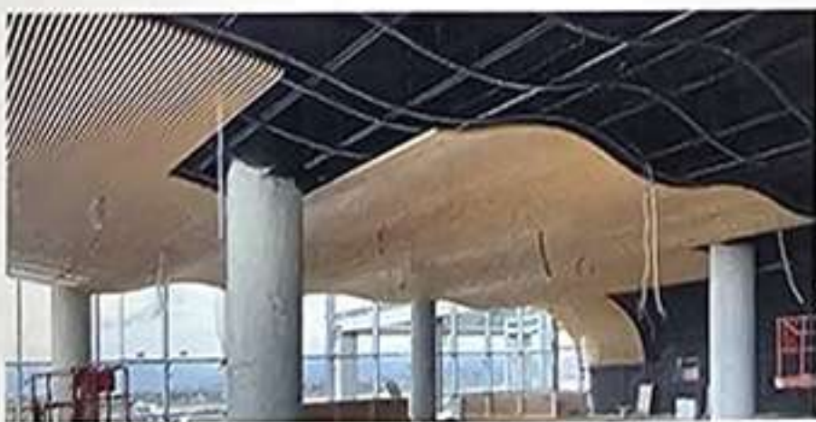
Fig. 1. Revestimiento de techo curvo de lamas de bambú y capiteles en la Sala Vip del Aeropuerto © Grupo GUBIA.
